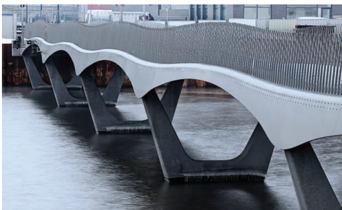
Vedere generală a podului Vluchthaven
