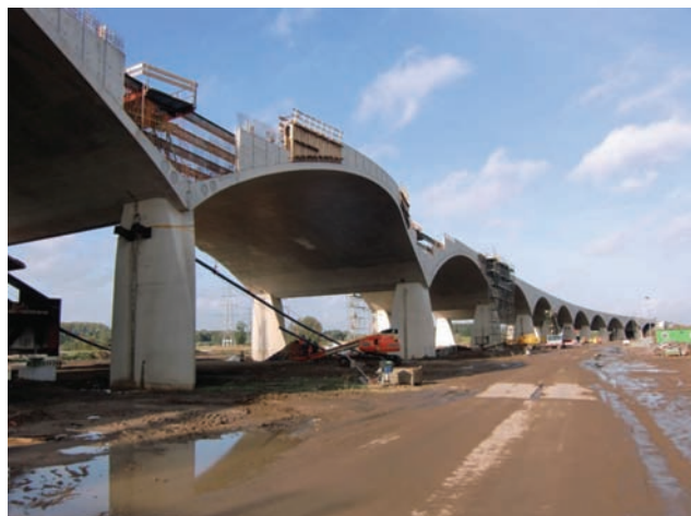
Imagini din timpul execuției podului
